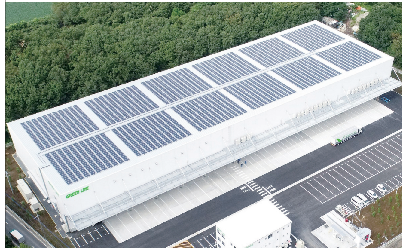
2020年11月にサービスを開始した、グリーン物流の所沢物流センターへの導入事例(744.15kW)
